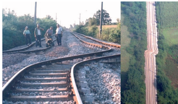
La photo montre une faille de décrochement qui a déplacé la voie ferrée. Photo prise lors du séisme d'Izmit, Turquie, le 17 août 1999.
