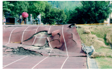
La photo montre une rupture avec faille inverse lors d'un séisme destructeur à Chi Chi, Taiwan en 1999. Gros plan sur la petite photo.
