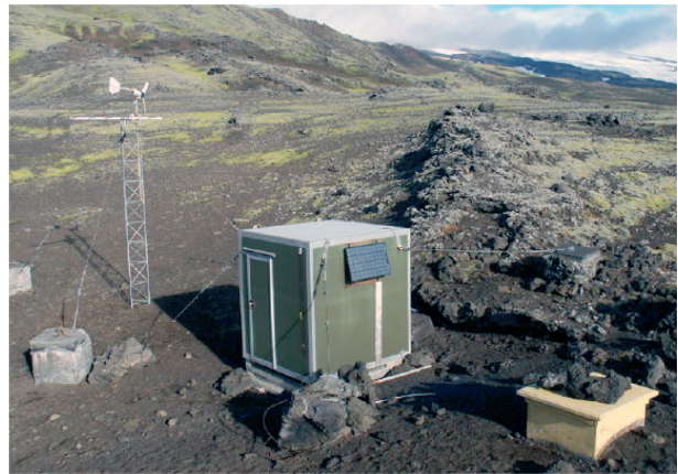
La station près de Beeremberg reçoit son énergie d'une éolienne et d'un panneau solaire. Le sismomètre est installé dans la boîte jaune à droite. Les données sont envoyées par radio à la base centrale de Jan Mayen.
