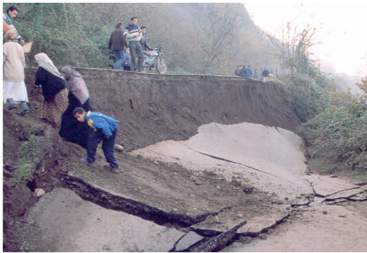
La photo montre une faille normale en relation avec un tremblement de terre destructeur en novembre 1999, près de Düzce en Turquie.
