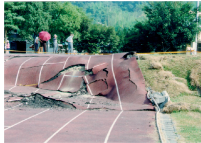
La foto muestra una ruptura de falla inversa relacionada con el terremoto destructivo de Chi Chi en Taiwan en 1999. La foto inferior muestra un primer plano de la foto superior.
