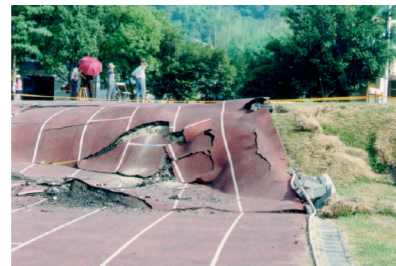
Das Bild zeigt eine Aufschiebung. Der Versatz entstand während des Chi Chi-Erdbebens 1999 in Taiwan.
